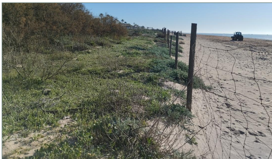
Ilustración 19: Vista del vallado sobre la cresta del primer cordón dunar.
