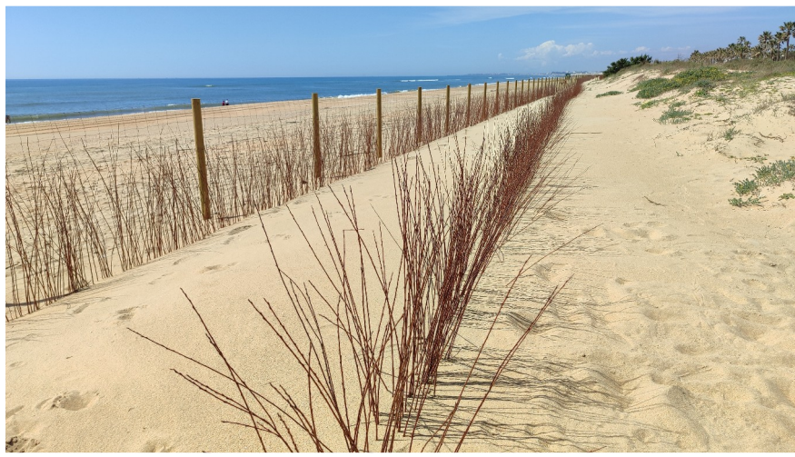
Captadores de arena para la regeneración y protección del sistema dunar de la playa de Islantilla.
