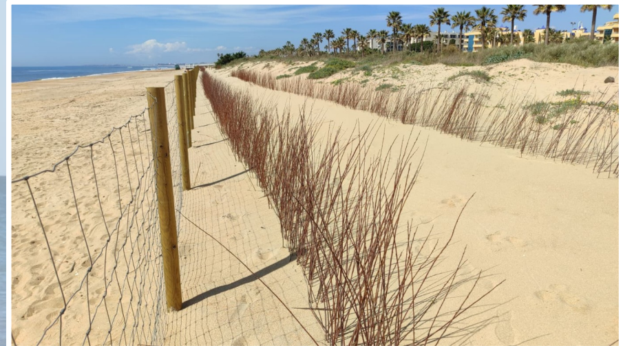
Captadores de arena para la regeneración y protección del sistema dunar de la playa de Islantilla.
