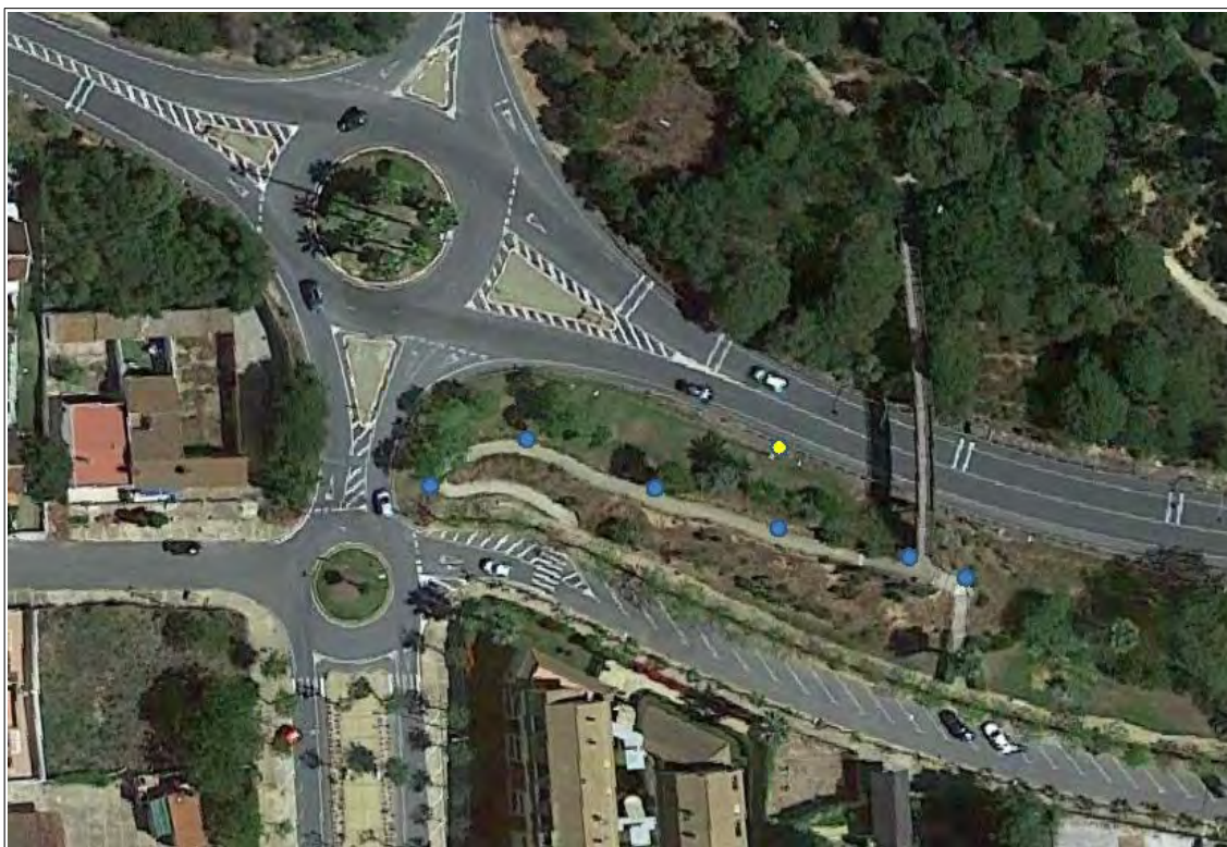
Pasarela de Poniente – MEJORA N.º 3
