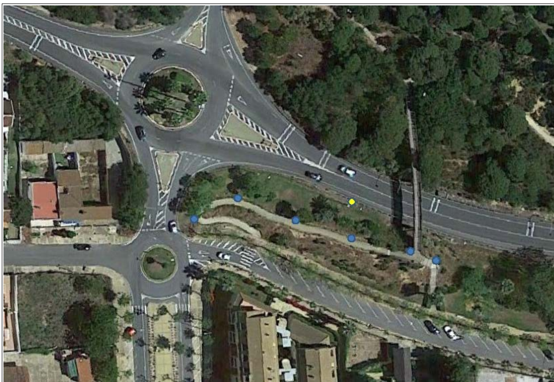
Pasarela de Poniente – MEJORA N.º 3
